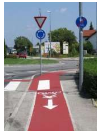
Slika 12: Ozka dvostranska kolesarska steza (Vir: Sečen, Ernest (2018). Promet kolesarjev v Brežicah. Brežice).
